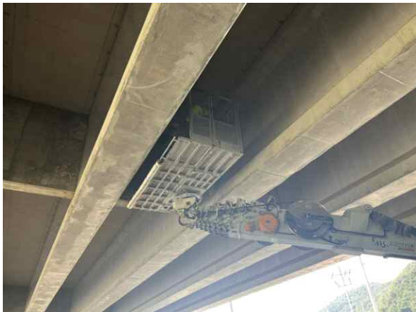
고소점검차를 이용한 근접조사
